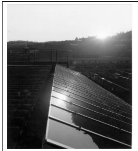
FIGURA 4: Vista da instalação fotovoltaica de 2kWp utilizando painéis solares de filmes finos de a-Si. A instalação de 40m 2 está voltada para o norte geográfico, com inclinação igual à latitude local (27°).
