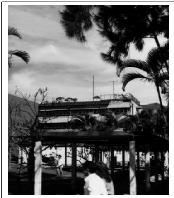
FIGURA 3: Vista do sistema solar fotovoltaico de 2kWp integrado ao prédio do LABSOLAR/UFSC e interligado à rede elétrica pública.
