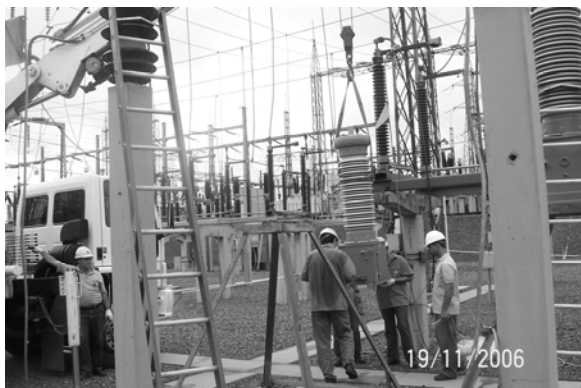
Fig. 11: Equipe técnica instalando DCP de 69 kV sobre base prismática em subestação, com auxílio de caminhão-guindaste
