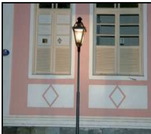
Figura 4 – Lâmpada em poste de aço
