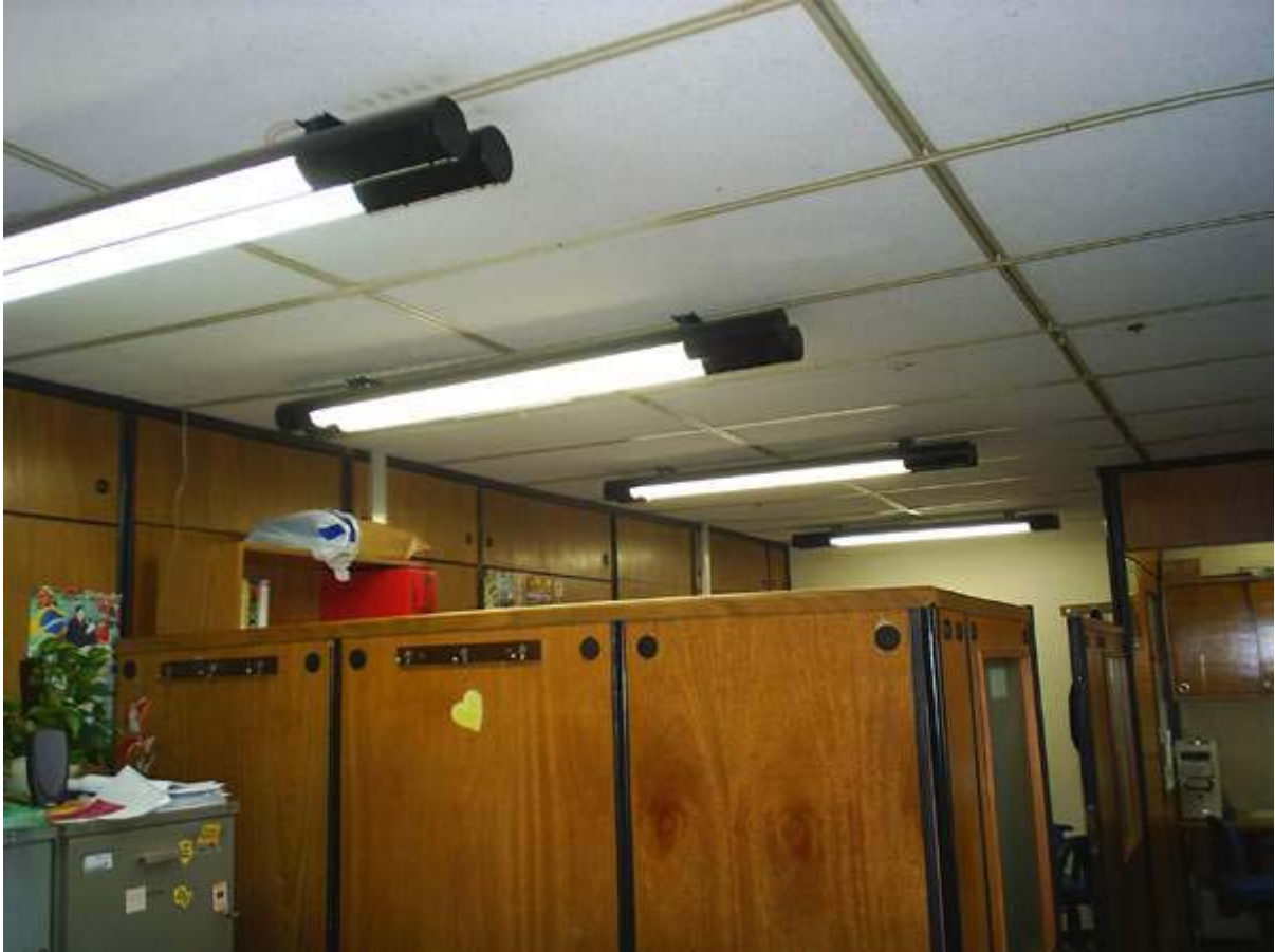
Luminária tubular preta, ineficiente.
