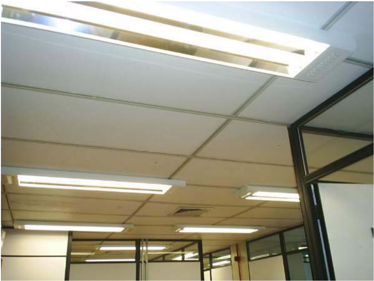
Gabinete com sistema de iluminação eficientizado
