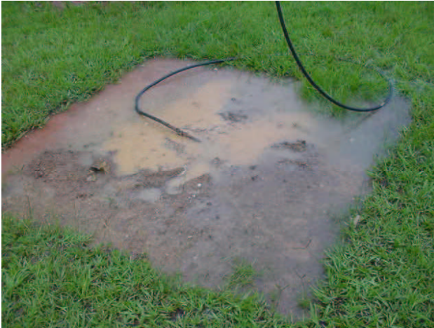
Figura 12 – Cabo caído na terra molhada.
