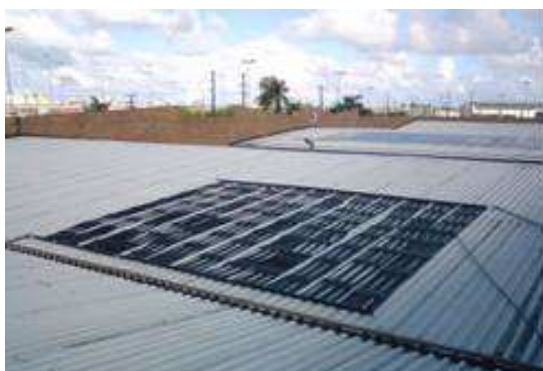
Imagens 05 e 06 – Tapetes de borracha EPDM que são os coletores solares instalados no telhado da AACD Recife/PE para aquecimento da piscina
