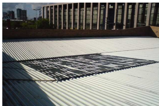
Imagens 05 e 06 – Tapetes de borracha EPDM que são os coletores solares instalados no telhado da AACD Recife/PE para aquecimento da piscina
