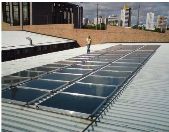
Imagens 07 e 08 – Placas coletoras e reservatórios de água instalados no telhado da AACD Recife/PE
