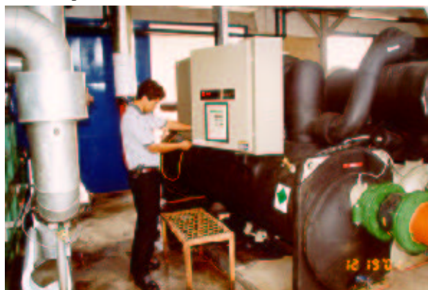
Foto 1 – Refrigerador (chiller) de alto rendimento
