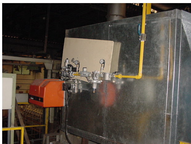
Foto 2 – Equipamento de injeção de gás em estufas
