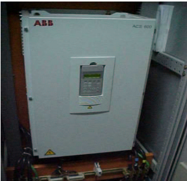
Foto 3 – Inversor de frequência em indústria de papeis
