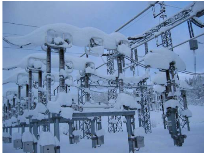
FIGURA 3 – Condições severas de neve – Seccionadores na Noruega
