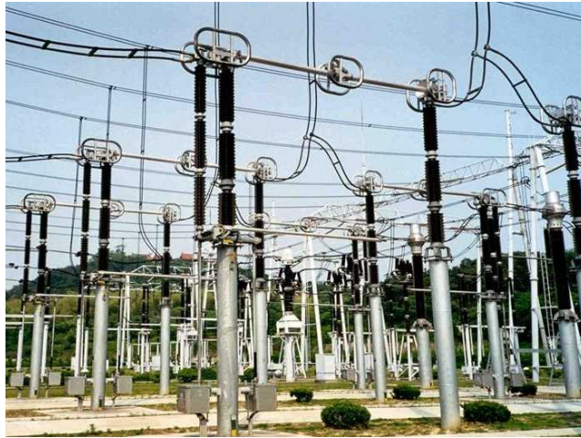
FIGURA 2 – Seccionadores semi pantográficos de 550 kV
