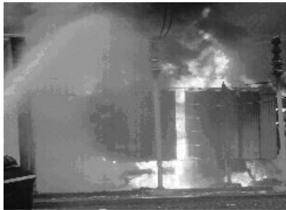
FIGURA 2 – Ruptura do Tanque
