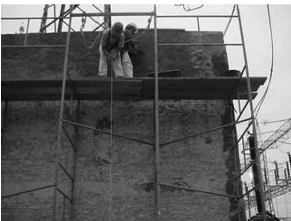
FIGURA 9 – Descascamento da parede corta-fogo
