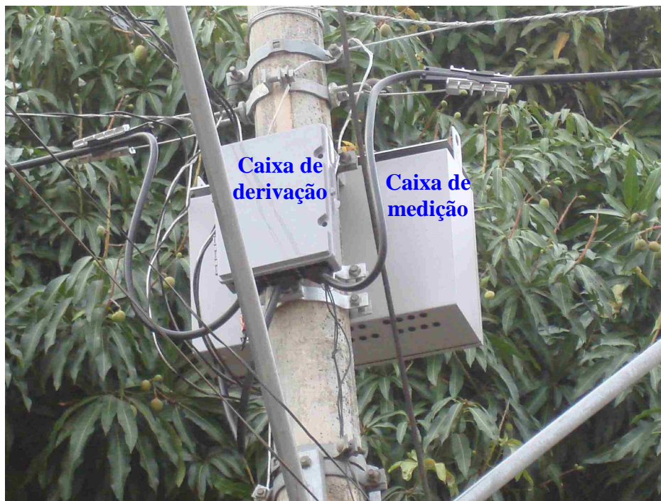
Figura 4 – Montagem de sistema de medição com rede RDC montado
