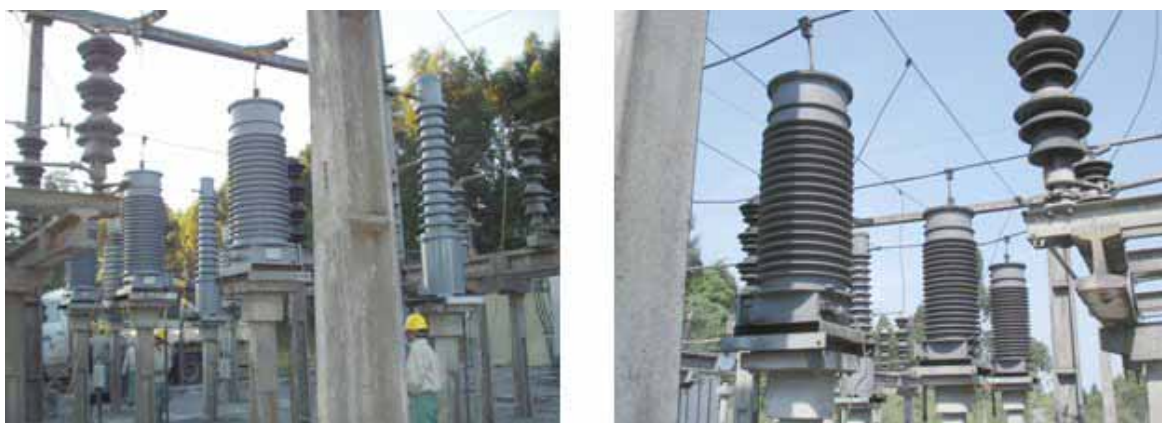
Fotos 9 e 10 – Transformadores de corrente e tensão após a aplicação da cobertura em 06/2004 e Após dois anos de exposição, respectivamente esquerda e direita.
