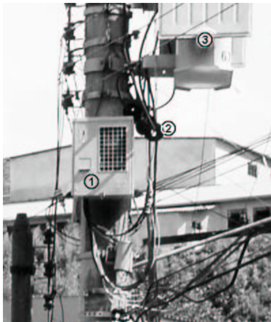
Figura 1 - Instalação típica de medidor totalizador
