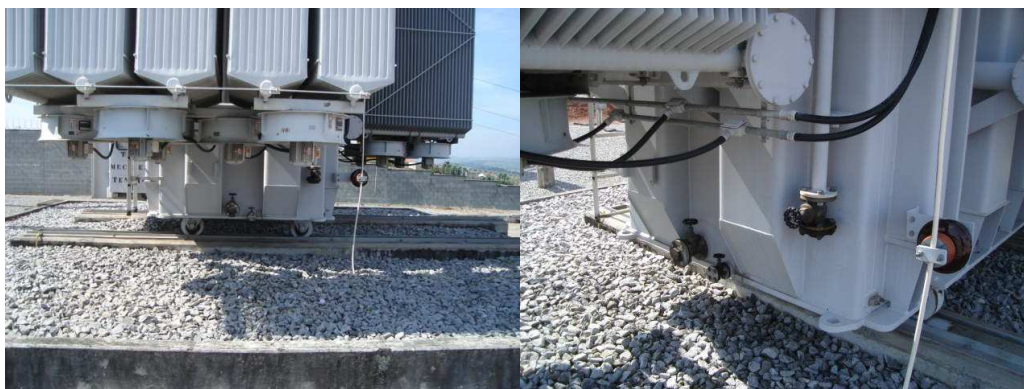
Fotos 2 e 3 – Vista inferior das válvulas de drenagem e coleta de óleo do transformador
