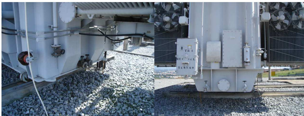
Fotos 4 e 5 – Exemplos de válvulas de drenagem de óleo em transformadores de grande porte
