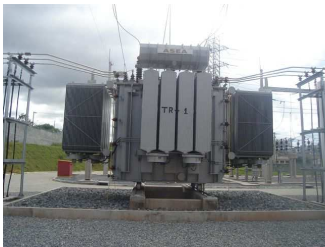
Foto 1 – Transformador de potência - 40/60 MVA
