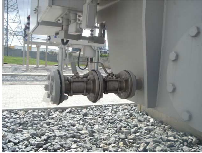
Foto 12 – Válvulas tipo esfera tripartida de aço inox
