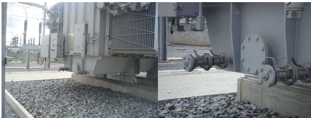
Fotos 9 e 10 – Válvulas de drenagem de óleo na nova configuração
