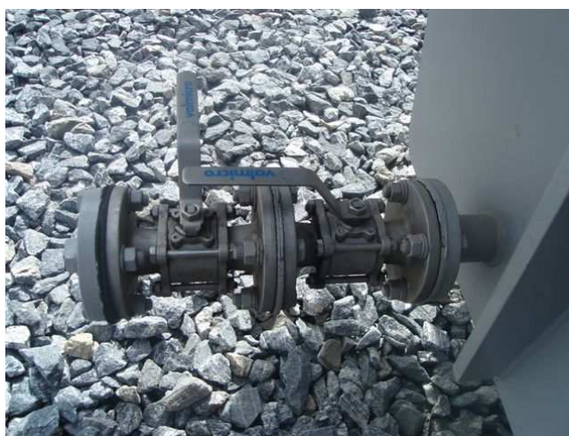
Foto 11 – Detalhe da posição das válvulas instalada (uma aberta e outra fechada)
