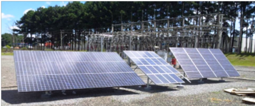
Figura 11 – Inversores Grid Tie Instalados
