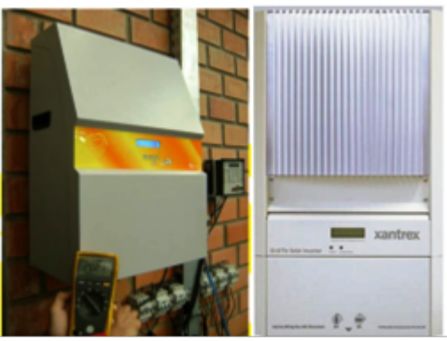
Figura 10 – Inversores Grid Tie Instalados
