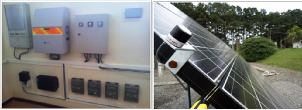
Figura 12 – Equipamentos e Dispositivos Instalados
