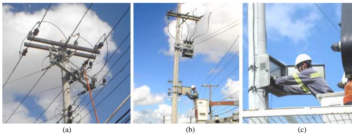
Figura 5 - (a) Chave de manobra tripolar, (b) Conjunto TP – TC – Medidor, (c) Leitura do medidor.
