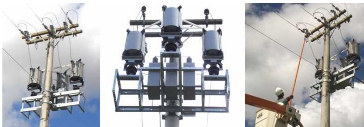
Figura 4 – Fotos do filtro instalado.
