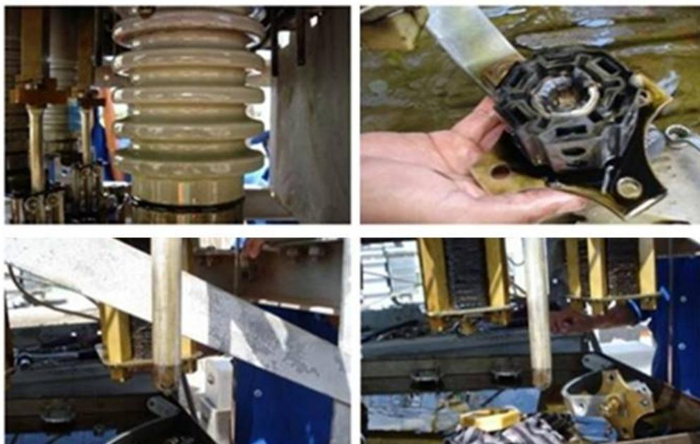
**Figura 2 – Avaliação dos componentes internos e coleta da borra do 21C4 SE CAM**
