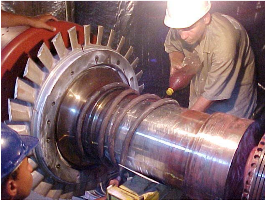
Figura 2 – Ensaio de Partículas Magnéticas (método da bobina) em munhão do gerador
