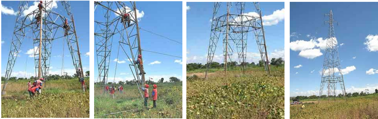
FIGURA 5: Operações de reforço com linha energizada nas torres H6L7 já implantadas
