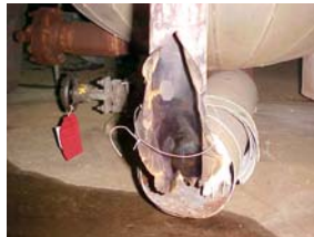
Figura 3: Aspecto visual da falha em rede de drenagem vapor úmido.
