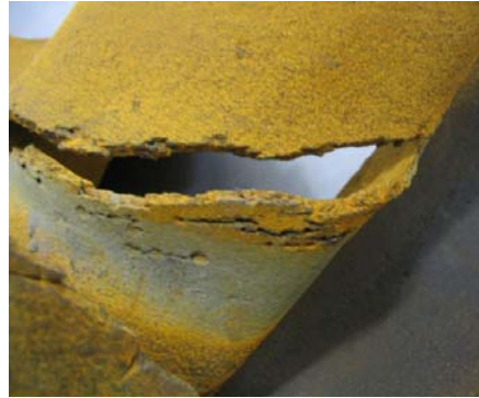
Figura 5: Aspecto da fratura frágil e presença de pites de corrosão.
