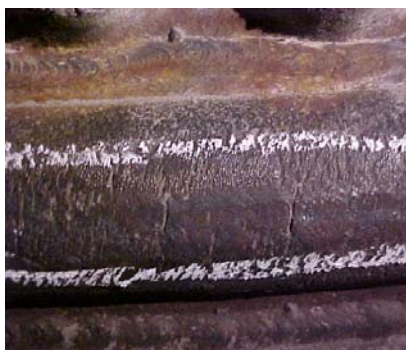
Figura 4: Trincas transversais em tubos do Evaporador (fornalha).
