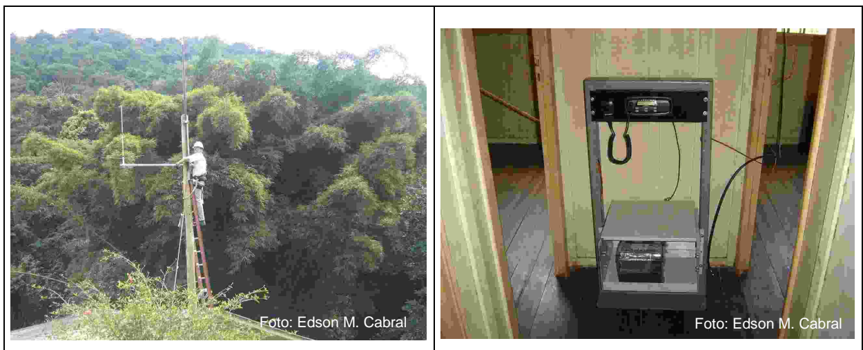
FIGURA 4 – Detalhe da instalação de rádio pelas equipes da COPEL
