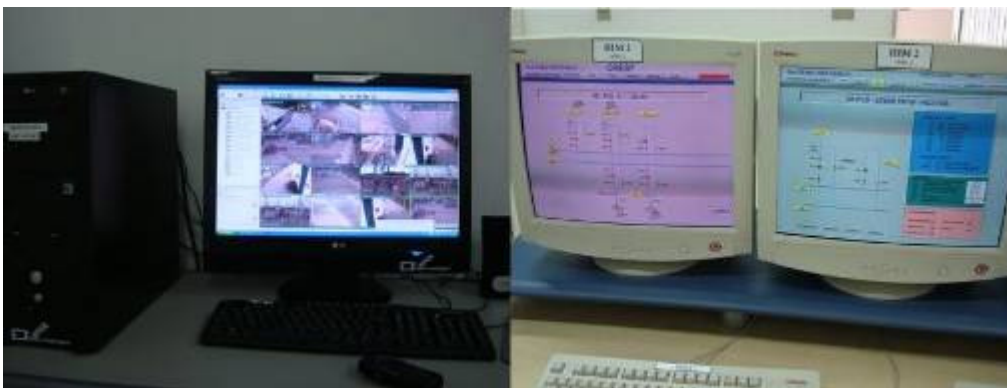
Figura 1 - Sistemas de CFTV e IHM isolados - Subestação Pici II
