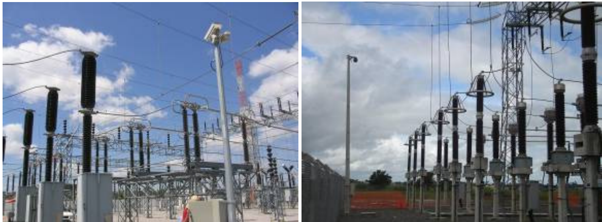
Figura 3 – Visualização de Chaves Seccionadoras – SEs Maceió e Sapeaçu
