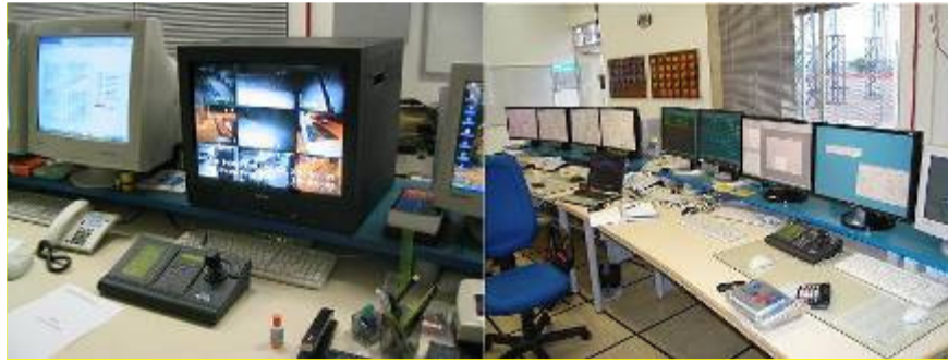
Figura 4 - Sistemas isolados de CFTV e IHMs - SE Paraíso
