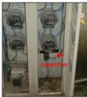
Figura 14 – Armário padrão com o conector instalado em um dos medidores.
