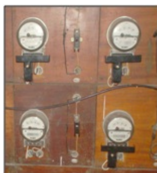
Figura 13 – quadro de medidores com os conectores instalados.
