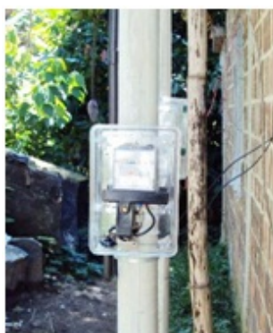
Figura 15 – conector instalado dentro de caixa de policarbonato.
