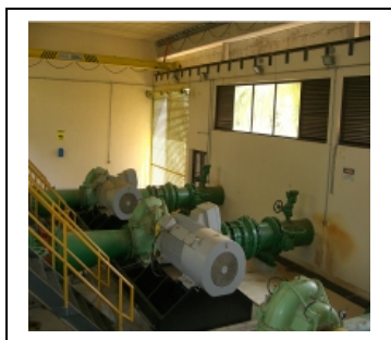
Figura 8. Motores de 500CV
