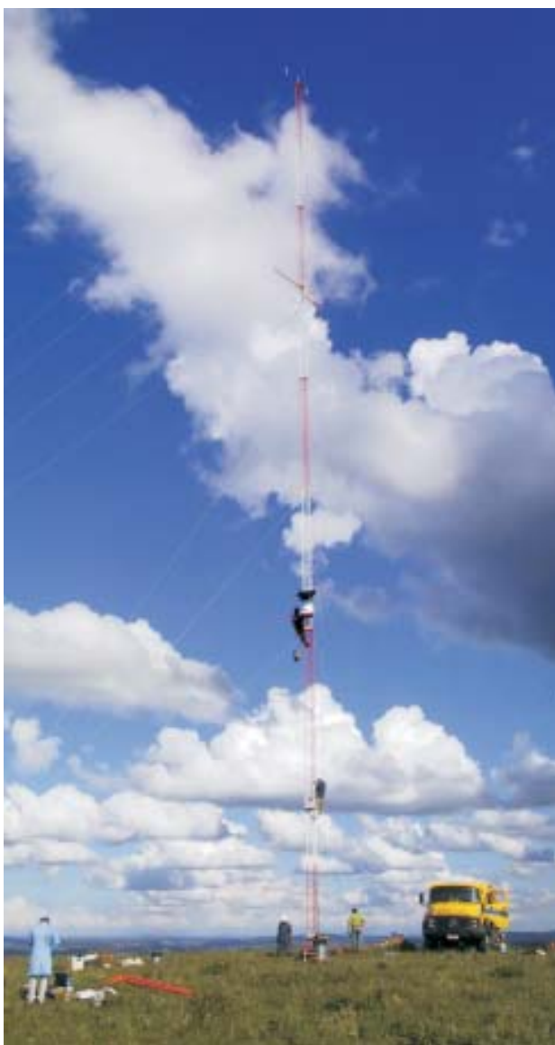
FIGURA 1.3 – (b) Torre anemométrica de 50 metros de altura.
