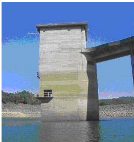
FIGURA 5 – Região do vertedouro na ocasião da estiagem (08 a 11/2006).
