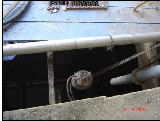
Fotos 03 e 04: Bomba submersa Flygt (catálogo e instalada).
