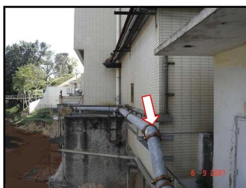
Fotos 08 e 09 - Nova tubulação feita para interligar a bomba submersa e o reservatório.
