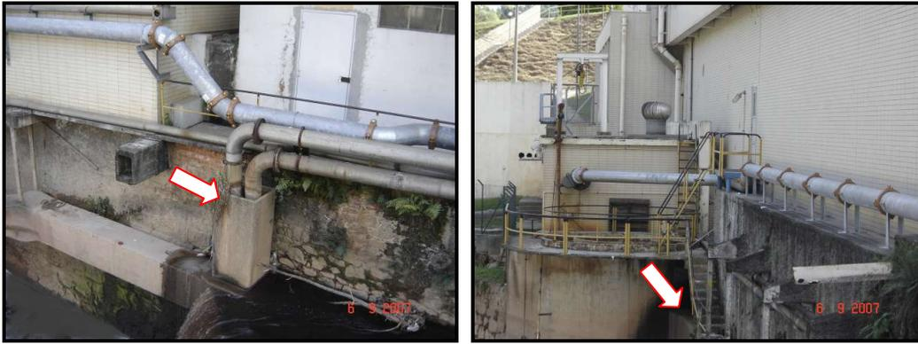
Fotos 10 e 11: Transbordamento de água eliminado no novo sistema de captação.
