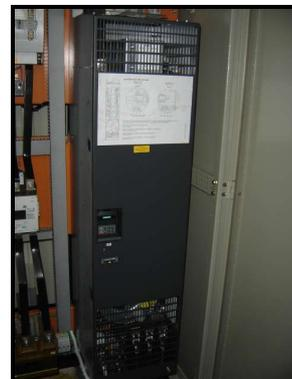
Fotos 05, 06 e 07: Painel do inversor de frequência alimentador da bomba.
