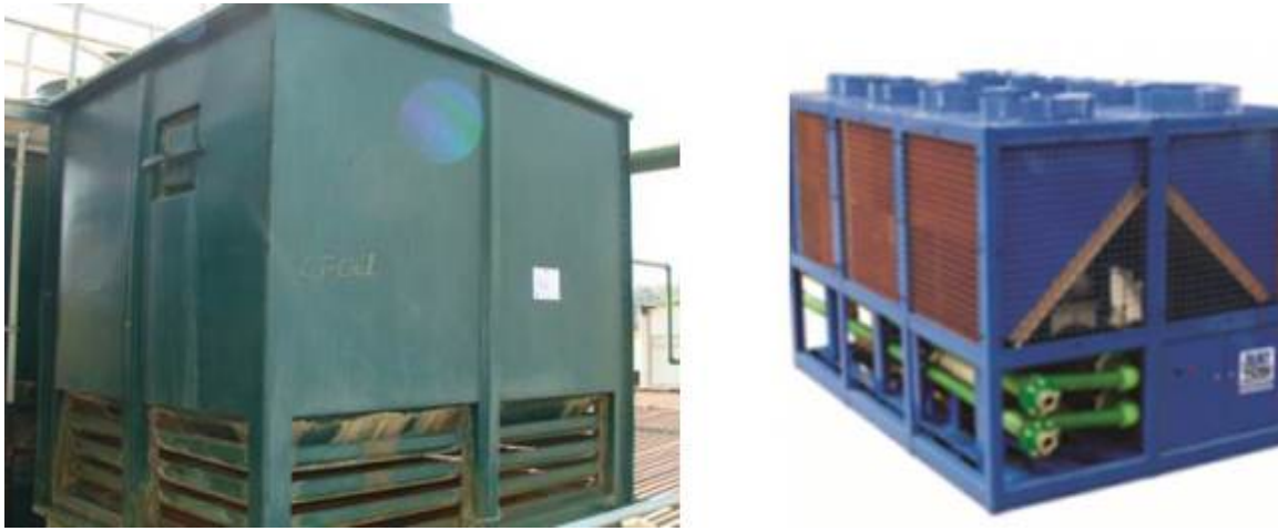
Figura 1 - Torre de resfriamento antiga e Turbocor utilizado na substituição
