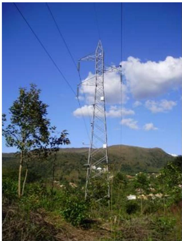
Figura 13. Sensores climatológicos instalados na estrutura 138 kV
