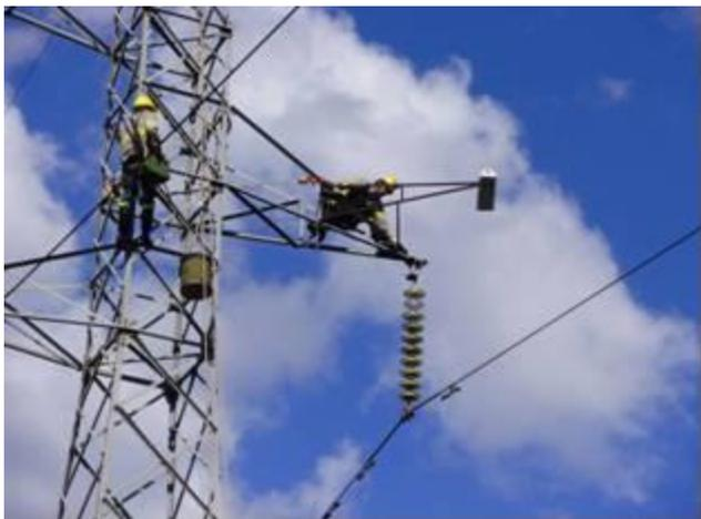
Figura 12. Instalação do sistema de medição de balanço.
