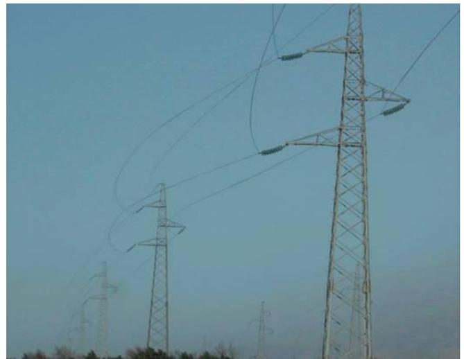
Figura 1. Balanço de cadeias de suspensão devido ao vento.
