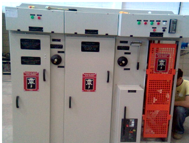
Conjunto blindado compacto isolado a ar para instalação interna
