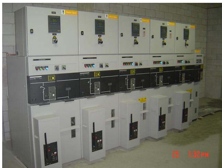
Conjunto blindado compacto isolado a ar/gás para instalação interna
