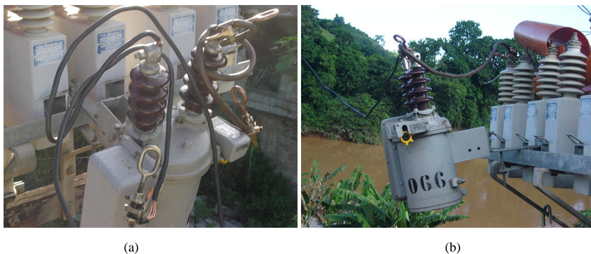
Figura 3 – Montagem em Linha Viva. (a).Kit.(b) Fixação do kit e conexão desse ao banco de capacitor.
