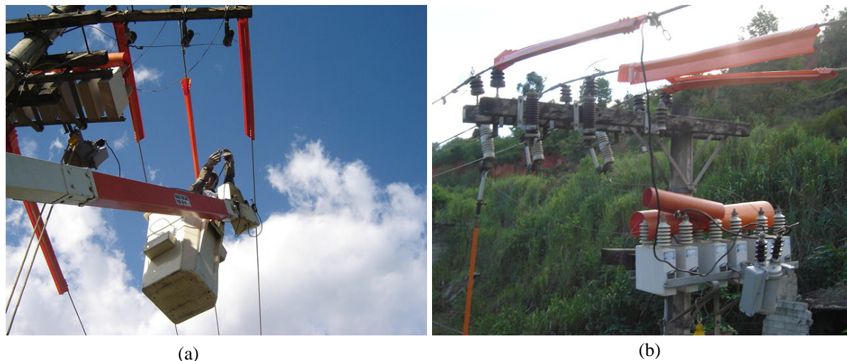
Figura 4 – Detalhamento da Instalação do kit em L.V. ao contato (a) Aplicação da conexão. (b) Conexão do terminal da chave à rede.
