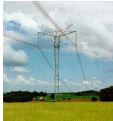
FIGURA 2 – Torre da LT de ± 600 kV
