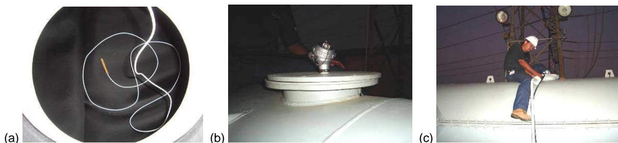
FIGURA 8 – Instalação do sensor de ruptura de membrana do tanque de expansão. (a) Sensor sobre a membrana, no interior do tanque; (b) Caixa de ligação no topo do tanque; (c) Conexão do cabo do sensor.
