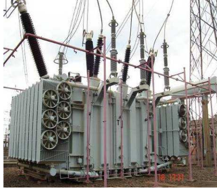
FIGURA 1 – Transformador regulador R1
