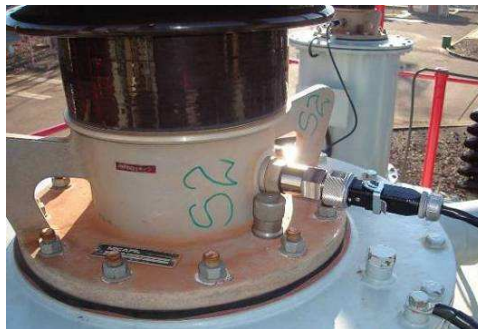
FIGURA 3 – Conexão direta do sistema de monitoração ao tap de bucha do lado Fonte
