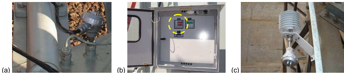
Figura 6 – Medição de temperaturas. (a) Sensor de temperatura do topo do óleo; (b) Monitor de temperatura do óleo e do ponto mais quente do enrolamento; (c) Sensor de temperatura ambiente.
