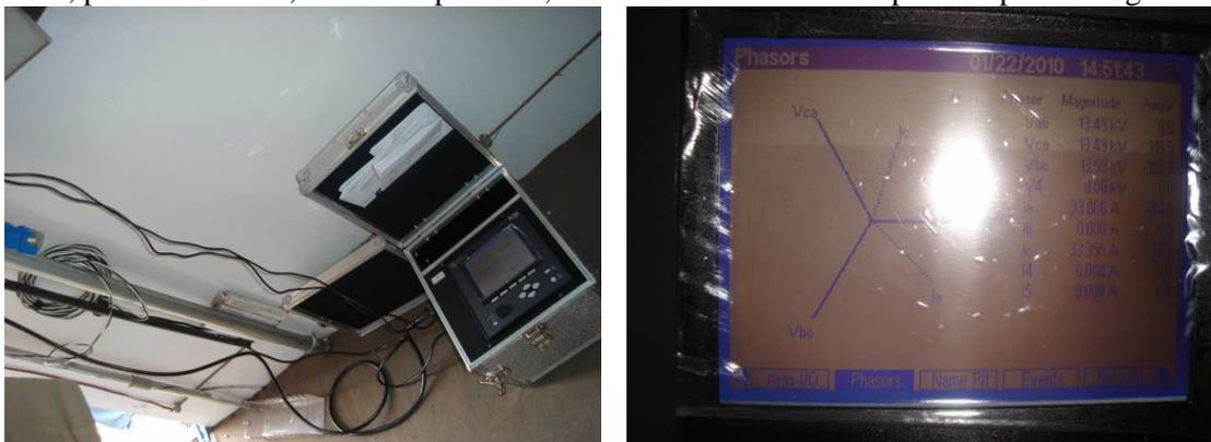
**Figura 4 – Qualímetro Power ION 7650 Instalado na Fundição – Seqüência de Fases**
