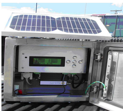
Fig.8 Fotografia da unidade concentradora - Detalhe de operação em campo
