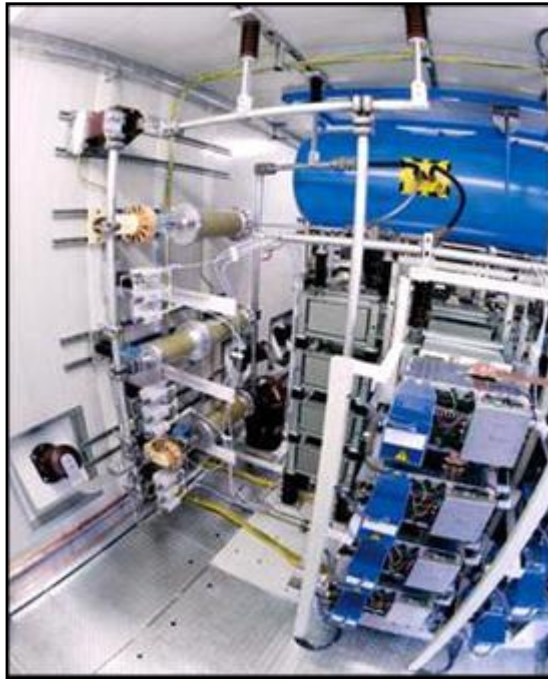
Figura 6 – Vista parcial do conversor e reator da fase A e também filtro para frequências elevadas, buchas e transformadores de corrente na parede do container
