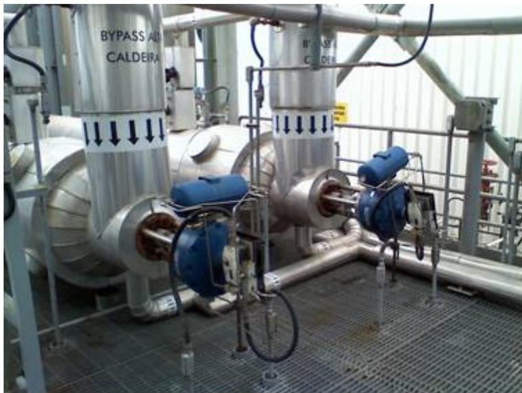
FIGURA 3 – Vista da válvula de desvio de vapor para o condensador.
