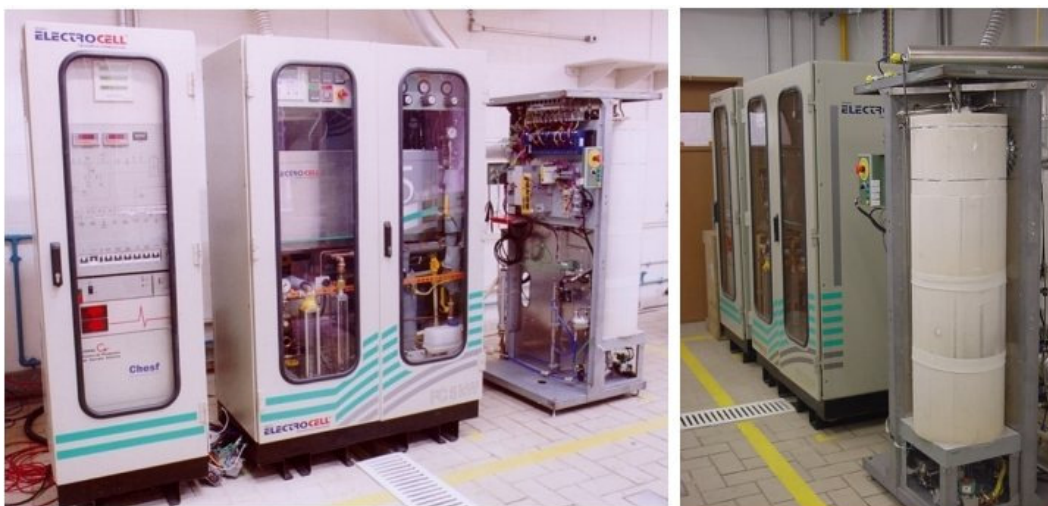
FIGURA 1 – Sistema de Geração Distribuída de Energia à base de célula a combustível de membrana polimérica trocadora de prótons do Laboratório de Células a Combustível do CEPEL.
