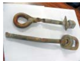
(b) – corrosão em ferragens
