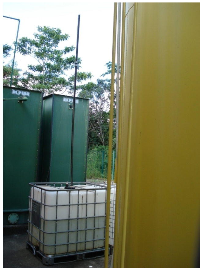
Figura 12: Sistema para neutralização do gás de purga.
