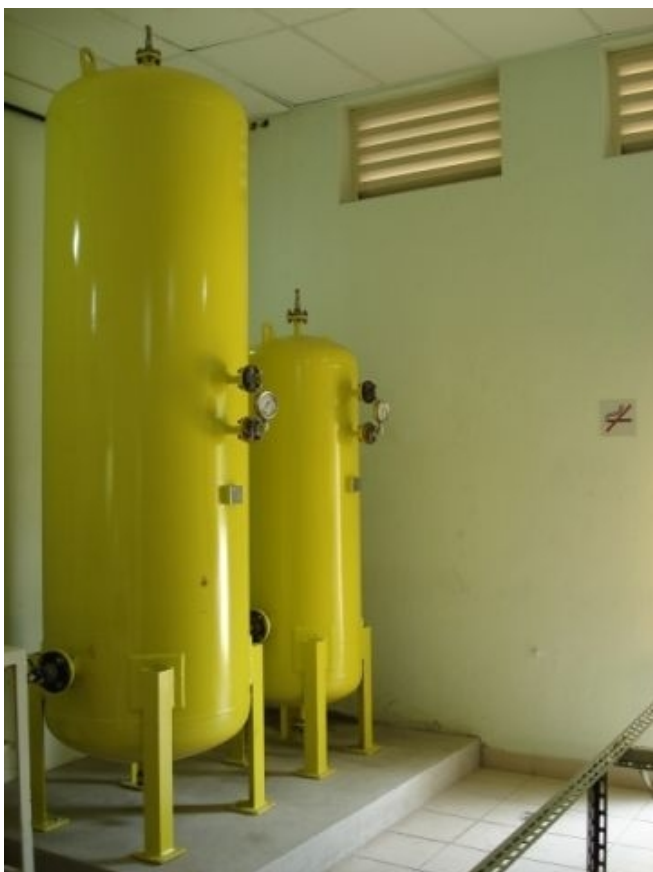
Figura 10: Sistema de armazenagem de gás.
