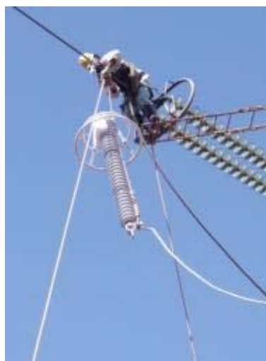
FIGURA 5 – Instalação de pára-raios ZnO nas estruturas
