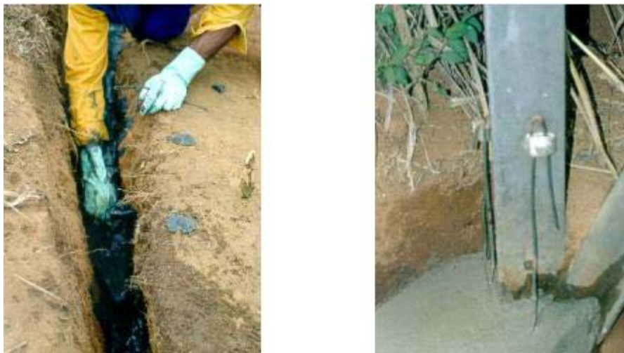
FIGURAS 2 e 3 – Aplicação de redutor químico nas estruturas 89, 93 e 120
