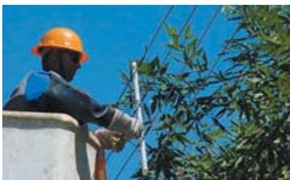
FIGURA 6. Instalação de Espaçadores
