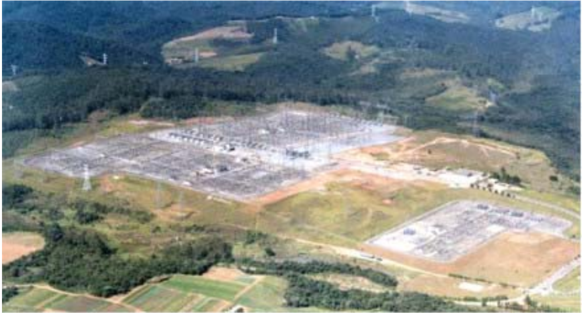
Figura 1 – Subestação de Tijuco Preto
