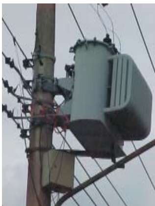
FIGURA 2 – Equipamento de medição junto ao transformador
