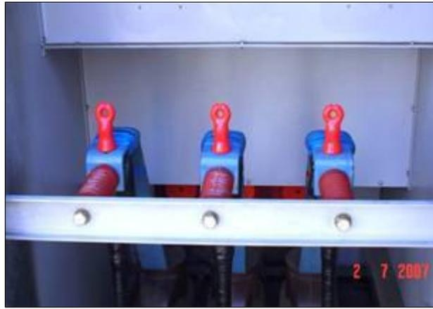
Figura 6 - ETD Canindé, barramento do blindado Marine Daminelli do circuito de distribuição CAI-104, solução completa com a cobertura de isolamento.
