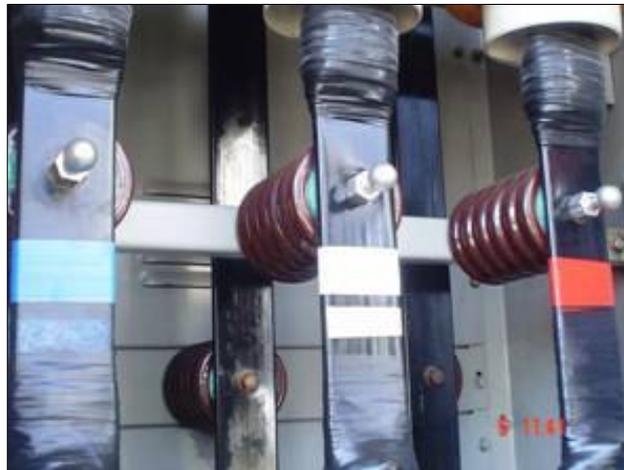
Figura 7 - ETD Gumercindo, barramento do blindado SACE do circuito de distribuição GUM-111, sem necessidade de furação no barramento de potência, utilizando a furação de conexão dos isoladores de suporte mecânico.
