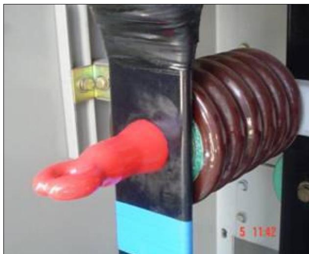
Figura 8 - ETD Gumercindo, barramento do blindado SACE do circuito de distribuição GUM-111, detalhe da cobertura de isolamento interna.
