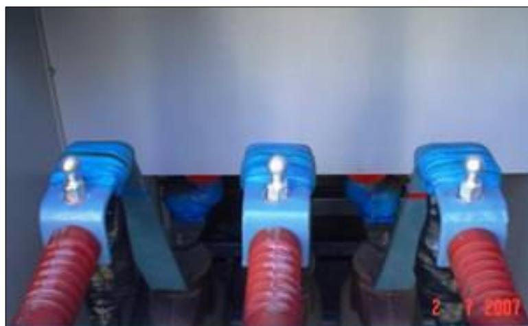
Figura 5 - ETD Canindé, barramento do blindado Marine Daminelli do circuito de distribuição CAI-104, com necessidade de furação no barramento de potência.
