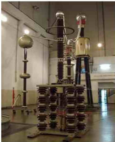
Figura 13. Montagem utilizada em laboratório para a medição de descargas parciais no pára-raios (em primeiro plano), utilizando-se o procedimento convencional de medição da carga aparente conforme a norma IEC 60270[3].
