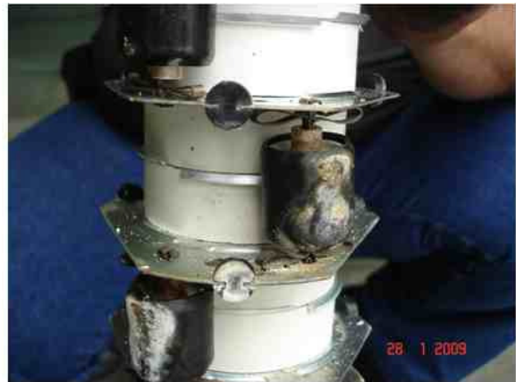
Figura 18. Estado dos capacitores internos prováveis fontes de descargas parciais
