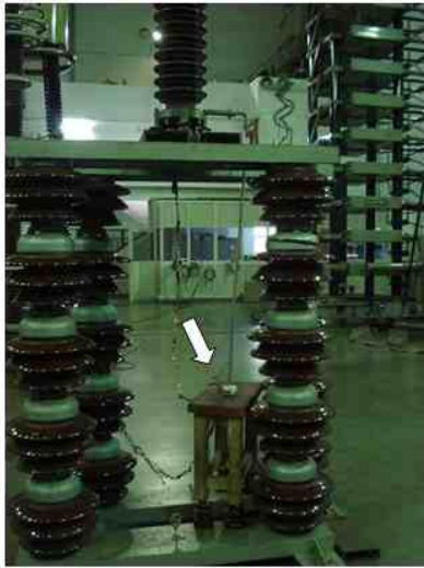
Figura 15. TC de alta frequência instalado no condutor de aterramento do pára-raios da fase AZUL.
