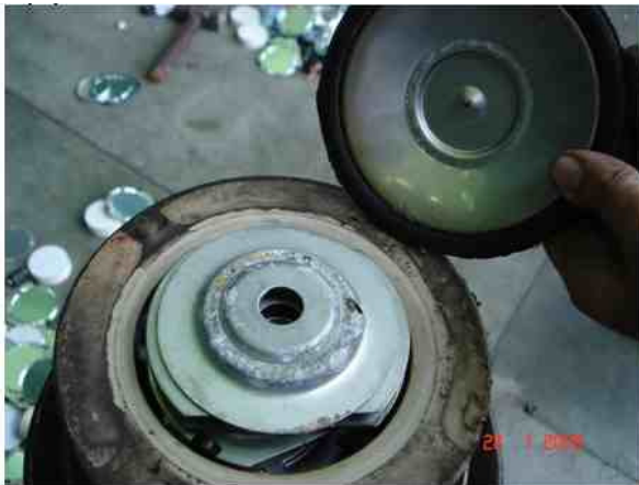
Figura 17. Estado interno do pára-raios, onde aparece a corrosão branca nas partes metálicas
