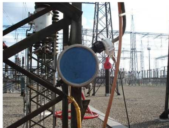
Figura 6. TC de alta frequência aplicado ao condutor de aterramento do pára-raios da fase AZUL
