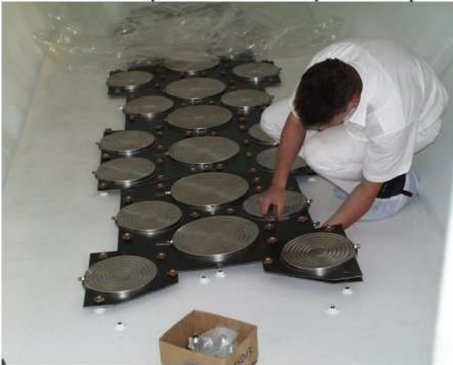
Figura 4 Membranas de absorção em montagem em um transformador de 250 MVA
