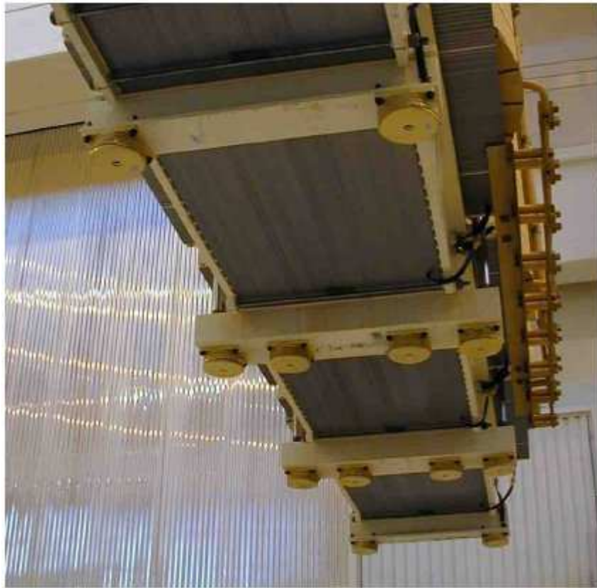
Figura 6 Isoladores de vibração montadas no mesmo reator de 150 MVAR
