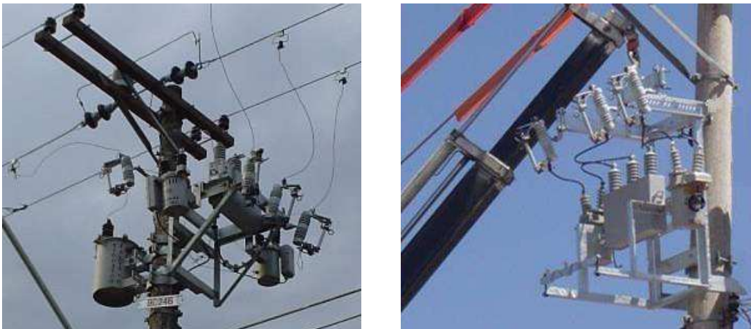
FIGURA 4 – Exemplo de Protótipo: Banco de Capacitor Relocável. A idéia original da esquerda foi desenvolvida para a da direita. No modelo final existem várias vantagens como: montagem no chão, posição das chaves, içamento num ponto e instalação sem linha viva.
