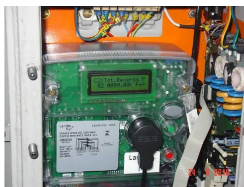
Figura 7 – Detalhe do circuito eletrônico instalado no transformador com medição integrada
