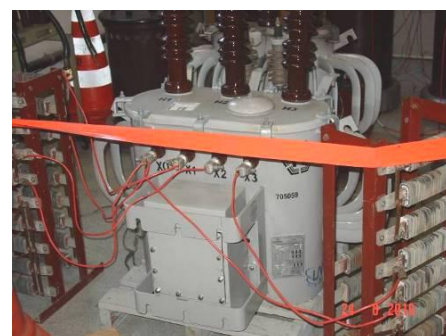
Figura 14 – Ensaio de avaliação funcional com carga aplicada aos terminais secundários
