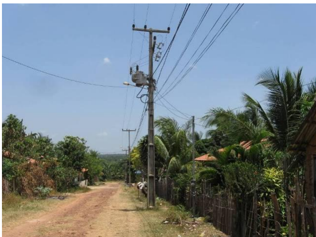
Figura 16 – Transformador com medição integrada em operação na rede de distribuição da CEMAR
