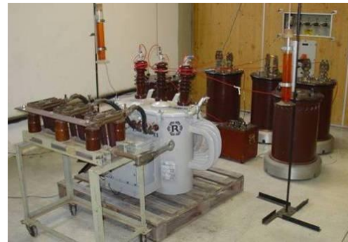
Figura 12 – Ensaio de elevação de temperatura com a aplicação de ciclos de carga
