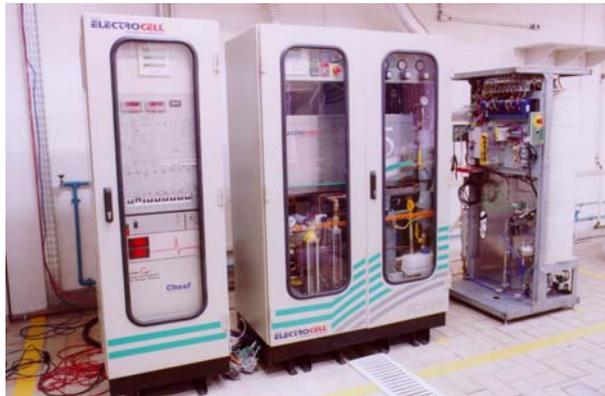
FIGURA 3 - CaC de membrana polimérica de 5 kW, e reformador de GN instalados no CEPTEL.
