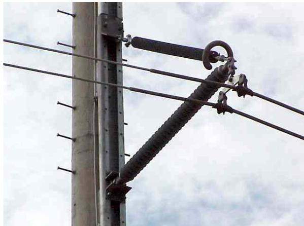
Figura 9 – Isoladores e o Trilho para Deslocamento das Fases
